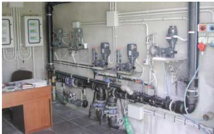
Impianto di fertirrigazione di un grande vivaio pistoiese
